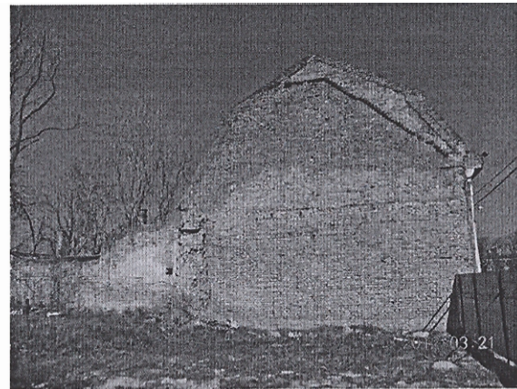
Szomszédos 210286 hrsz.-ú ingatlan kerítése és épülete
