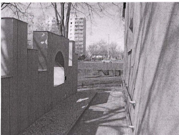
Az épület előtti falszerkezet és akadálymentes rámpa
